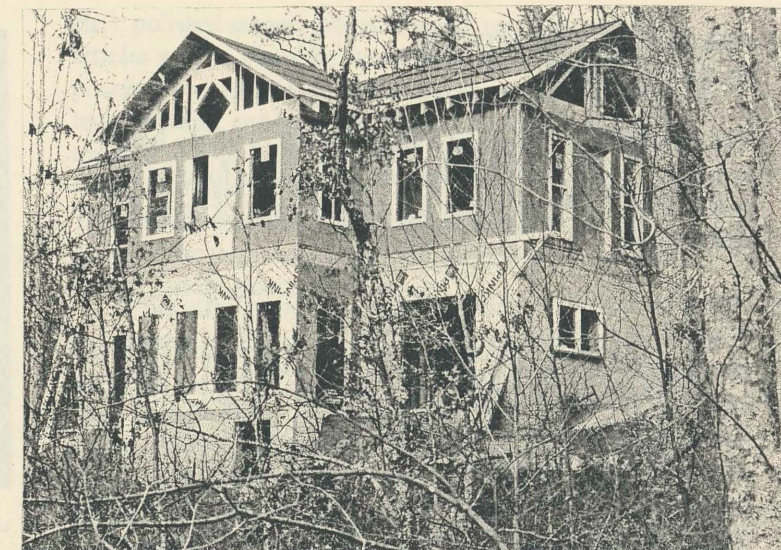
Progress up til Solstice
